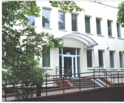
Przychodnia Rejonowo-Specjalistyczna ul. Łojewska 6
