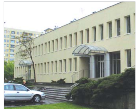
Przychodnia Rejonowo-Specjalistyczna ul. Rembielińska 8
